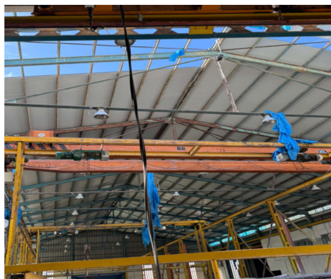
Cubierta sobre la que colocaban los paneles sándwich como base para la posterior instalación de los módulos solares.
