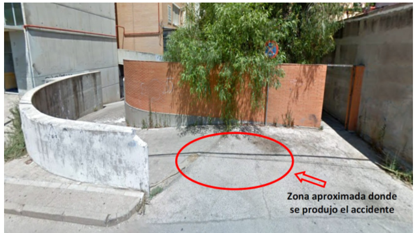
Imagen del muro previa al accidente (obtenida de google maps). Delimitación de la zona aproximada de ocurrencia del accidente.
