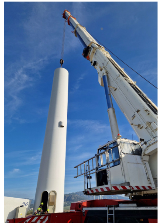
Realizaban el desmontaje del aerogenerador con ayuda de camiones grúa que retiraban sus componentes.
