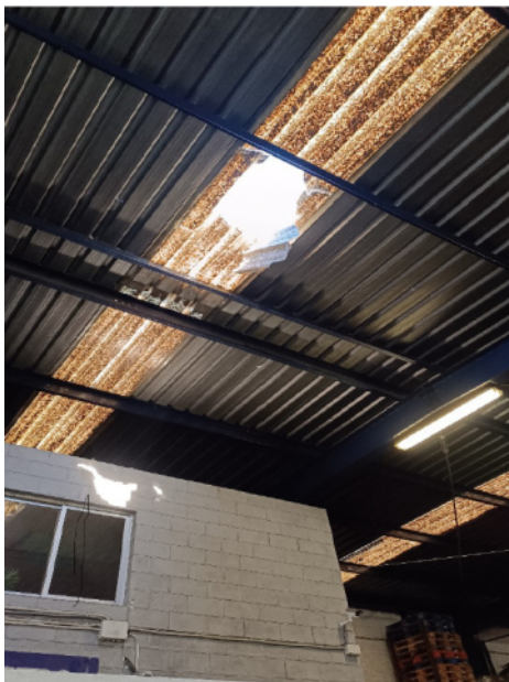
Lucernario roto por el que cayó el trabajador desde 8 metros de altura.
