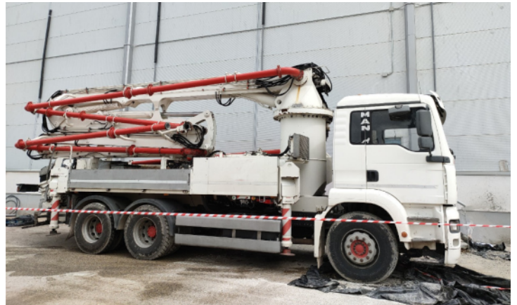
Autobomba que suministraba el hormigón.
