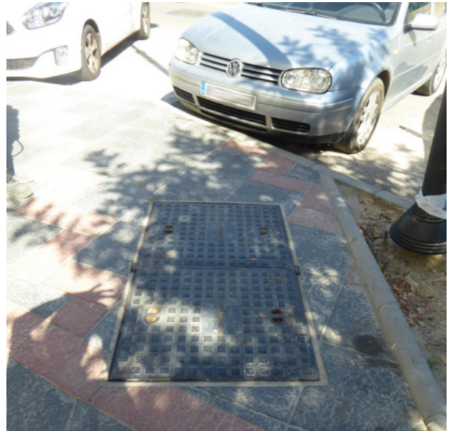
Vista de la arqueta con las dos tapas de fundición dúctil colocadas en su posición.
