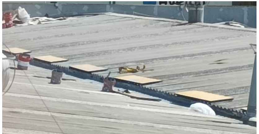
Lugar del accidente. Se aprecian los cubos impermeabilizantes y los tableros de encofrado para conformar un pasillo de tránsito a todo el largo de la cubierta.
