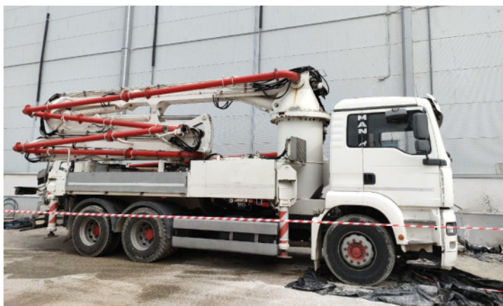
Autobomba que suministraba el hormigón.
