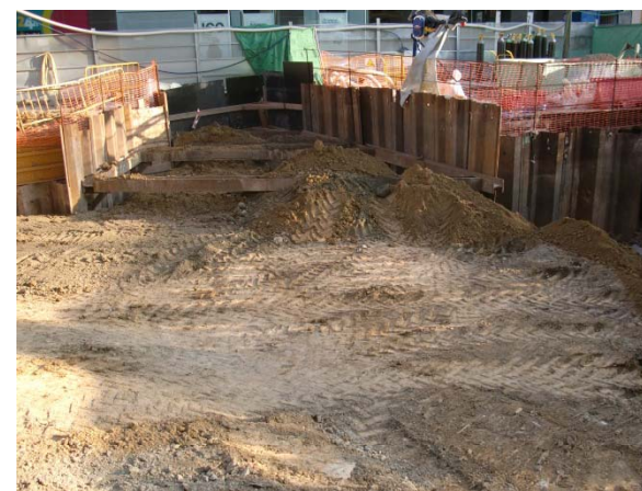
Relleno total de la zona explorada y protegida
