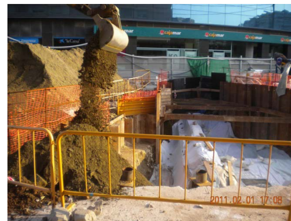
Relleno total de la zona explorada y protegida
