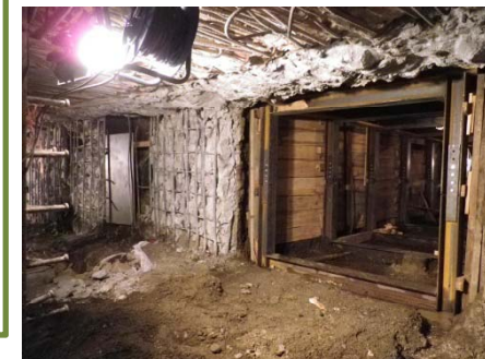
VIGA LONGITUDINAL Nº 5. EN EXCAVACIÓN P.k. +
