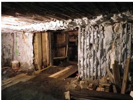
VIGA LONGITUDINAL Nº 5. EN EXCAVACIÓN P.k. -
