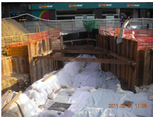
Protección de todo el conjunto con Geotextil
