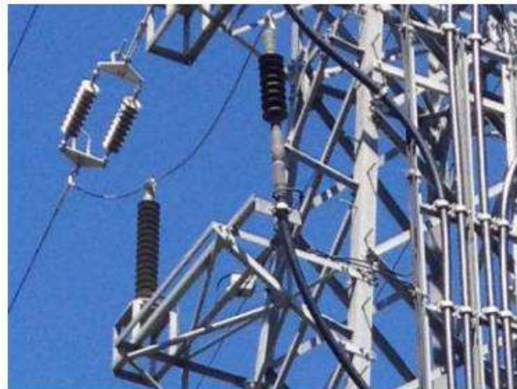
Unión conductor aéreo-pararrayos-terminal
