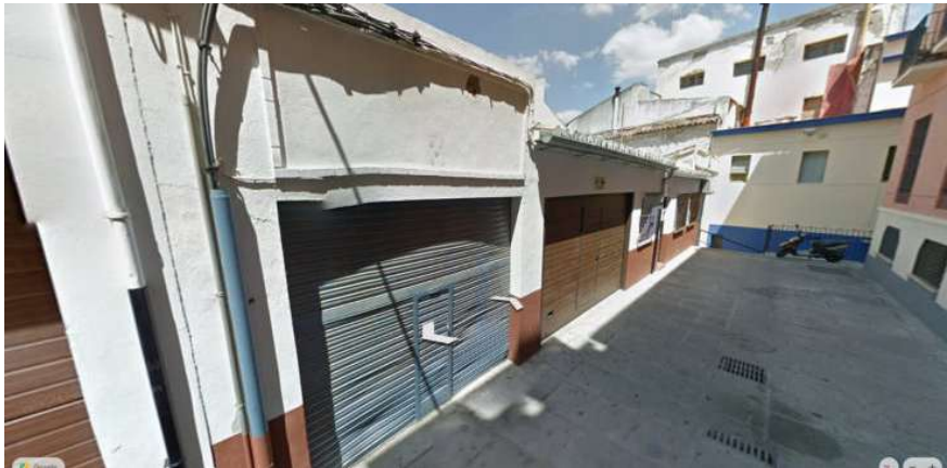
Imagen de las las tres construcciones existentes en las parcelas a agregar (Parcelas 3, 4 y 5)
