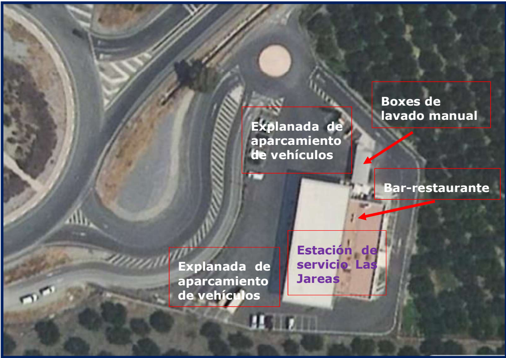
Vista aérea de la EE.SS. Las Jareas. Término municipal de Motril.
