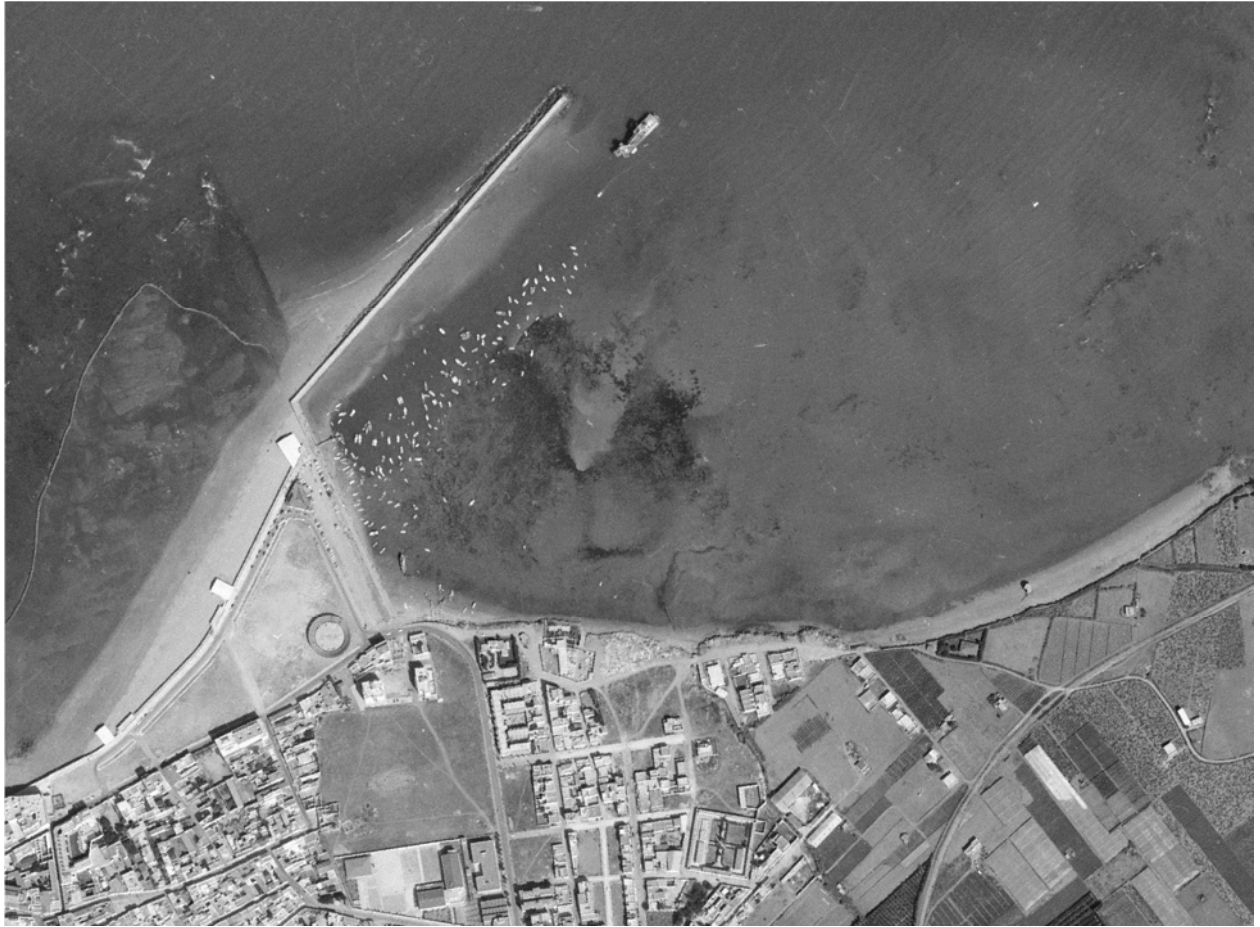
Fig. 4. Puerto de Chipiona en 1984. Se observa una draga trabajando y la flota a resguardo del dique
