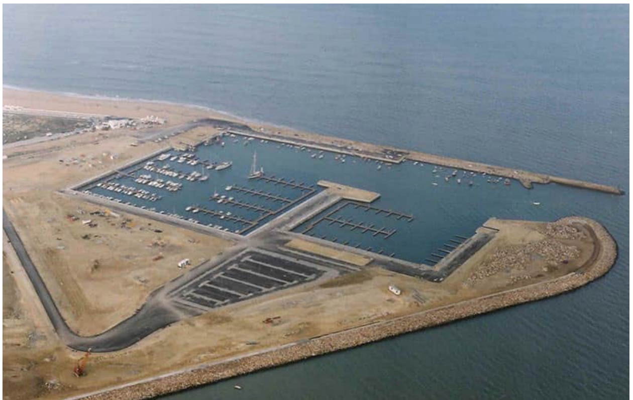
Fig. 5. Puerto de Chipiona en 1990 con las principales infraestructuras ya construidas.
