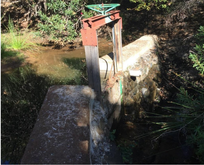
Figura 5: presa con compuerta de la captación. Imagen tomada de la memoria técnica aportada
