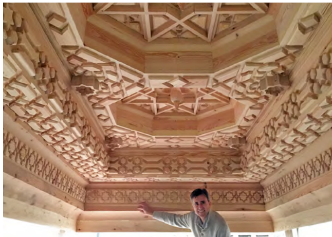
Reconstrucción del Artesonado Mudéjar del Monasterio de Sijena. Artesonados Mudéjares ©
