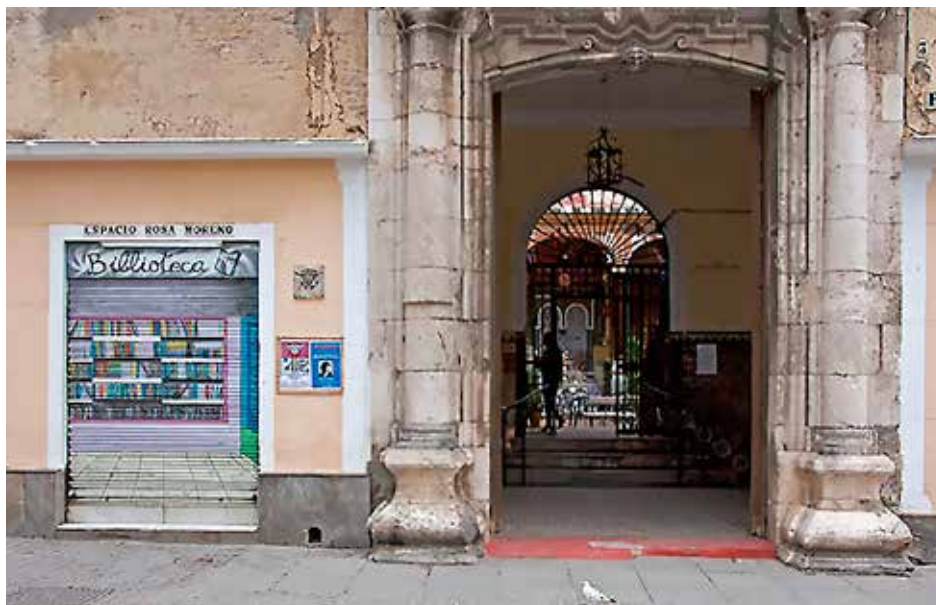
Figura 5.8.1 Zaguán y Biblioteca de la Casa del Pumarejo.
