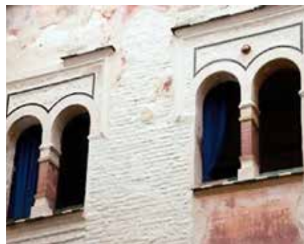
Figura 5.8.21 Ventanas del piso principal.
