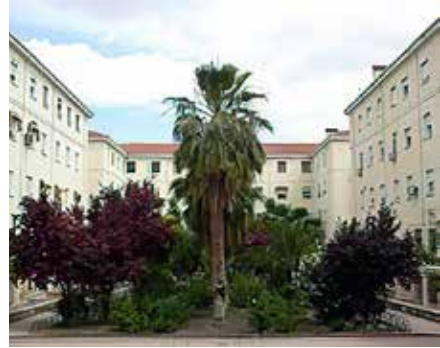
Figura 5.6.6 Patio interior de manzana entre calles Andújar, Avenida de la Estación, Linares y Fermín Palma.
