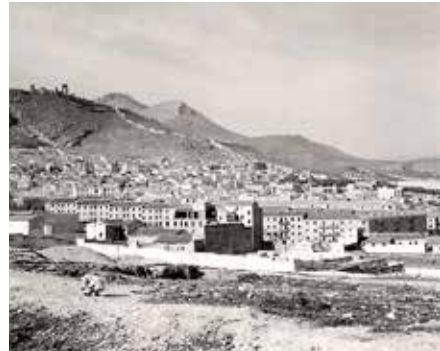
Figura 5.6.3 Las Protegidas en construcción.
