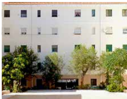
Figura 5.6.13 Fachada al patio de manzana en calles Andújar, Estación, Linares y Fermín Palma.
