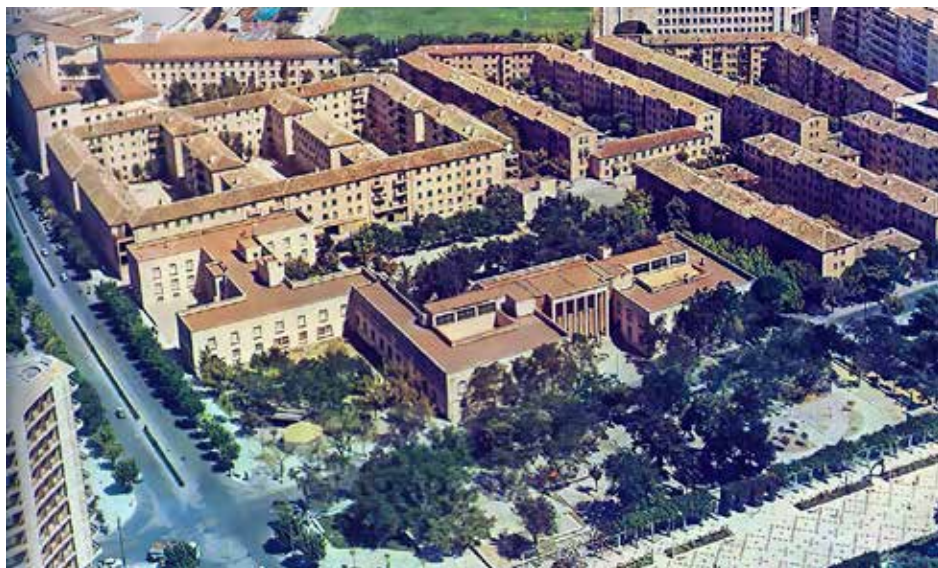
Figura 5.6.1 Vista general de las Viviendas Protegidas de Jaén (años 70).
