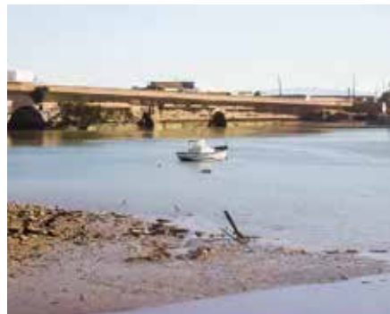
Figura 5.2.4 Puente Suazo. San Fernando.
