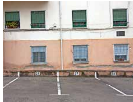
Figura 5.6.10 Zonas de los patios interiores convertidas en aparcamientos vecinales.
