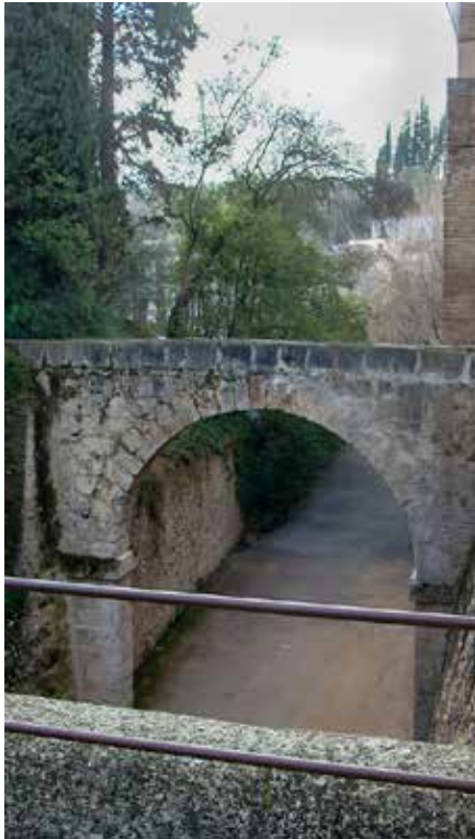
Figura 5.4.9 Acequia Real en la Alhambra.
