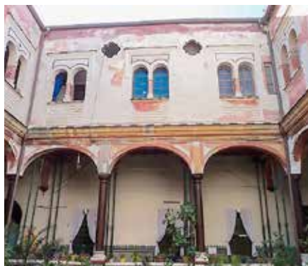
Figura 5.8.13 Arcadas y ventanas superiores del patio principal.
