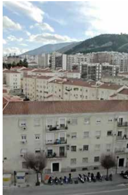
Figura 5.6.7 Vista de las Viviendas Protegidas desde la acera de El Corte Inglés.
