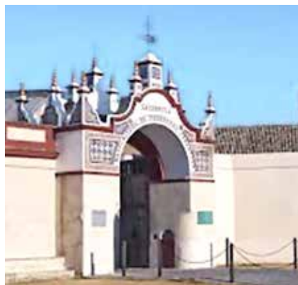
Figura 6.3.3 Instituto Andaluz del Patrimonio Histórico.
