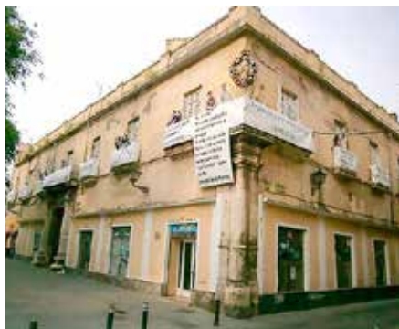
Figura 5.8.6 Esquina a calle Fray Diego de Cádiz.
