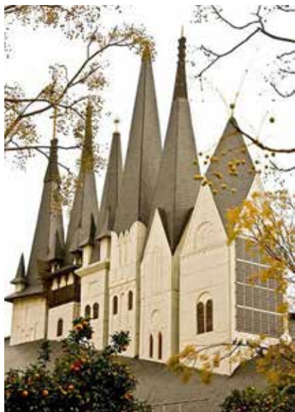
Figura 3.3.3 Pabellón de Hungría, Expo 92 (Sevilla).
