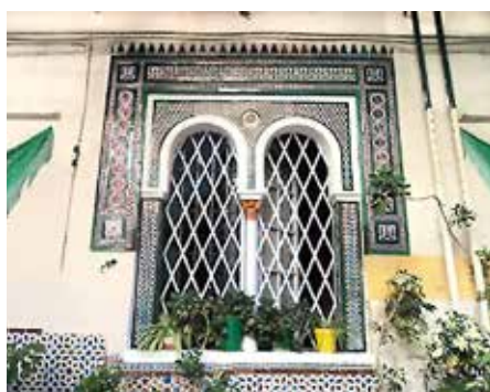
Figura 5.8.17 Ventana en galería inferior del patio principal.
