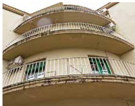
Figura 5.6.12 Balcones en esquina en calle Úbeda.
