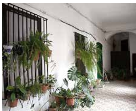
Figura 5.8.18 Vista de la Galería superior.
