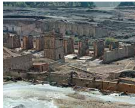
Figura 5.5.8 Instalaciones en desuso.
