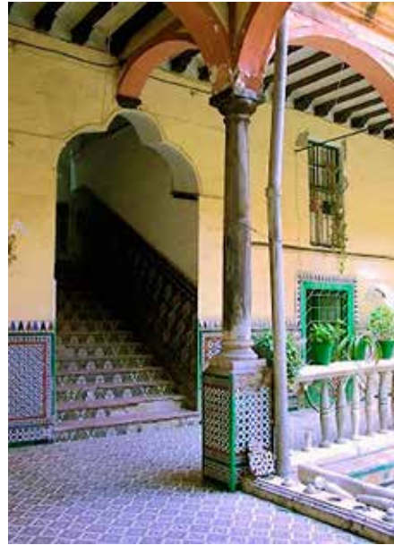
Figura 5.8.9 Crujía escalera principal.
