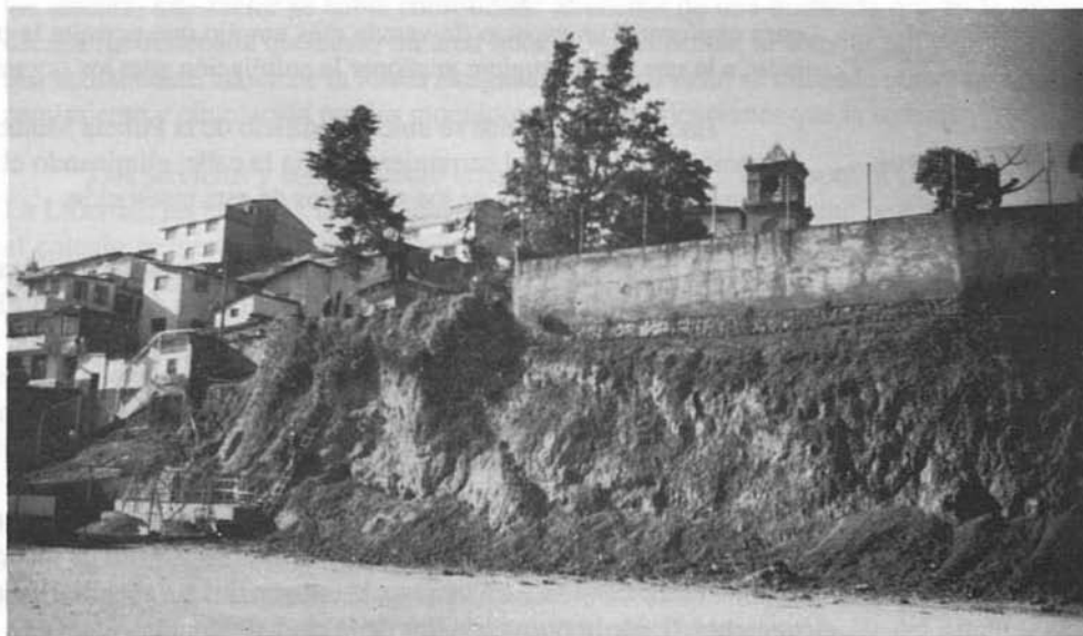
Area recreativa, antes de la intervención.
