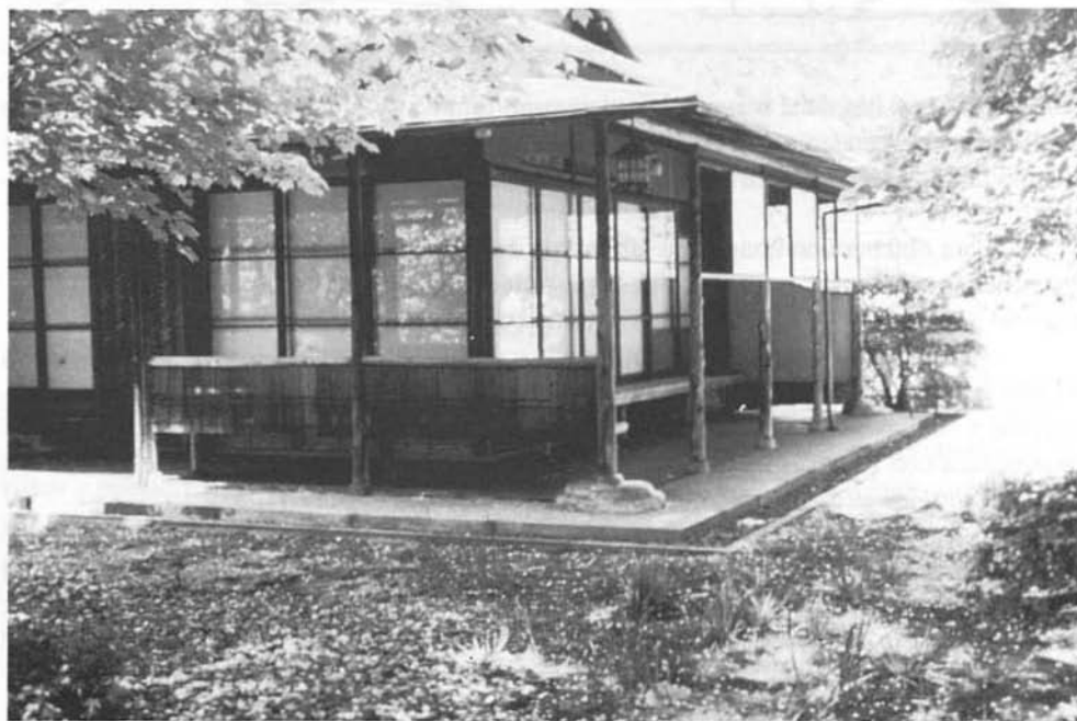
Katsura. Casita del té (arriba). Cancillería del Japón en Washington, Casi- ta del té antes de ser trasladada (abajo).
