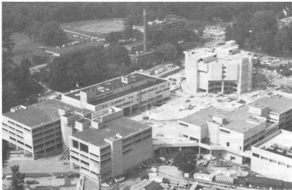
Proyecto Universidad de Georgetown. Washington. (arriba) Universidad del Distrito de Columbia. Proyecto en construcción. (abajo)
