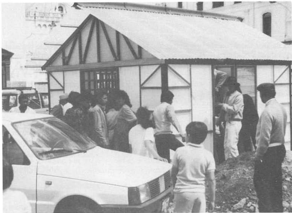
Caseta de protección de las excavaciones en la Plaza de Santo Domingo que permitió el seguimiento de las investigaciones.
