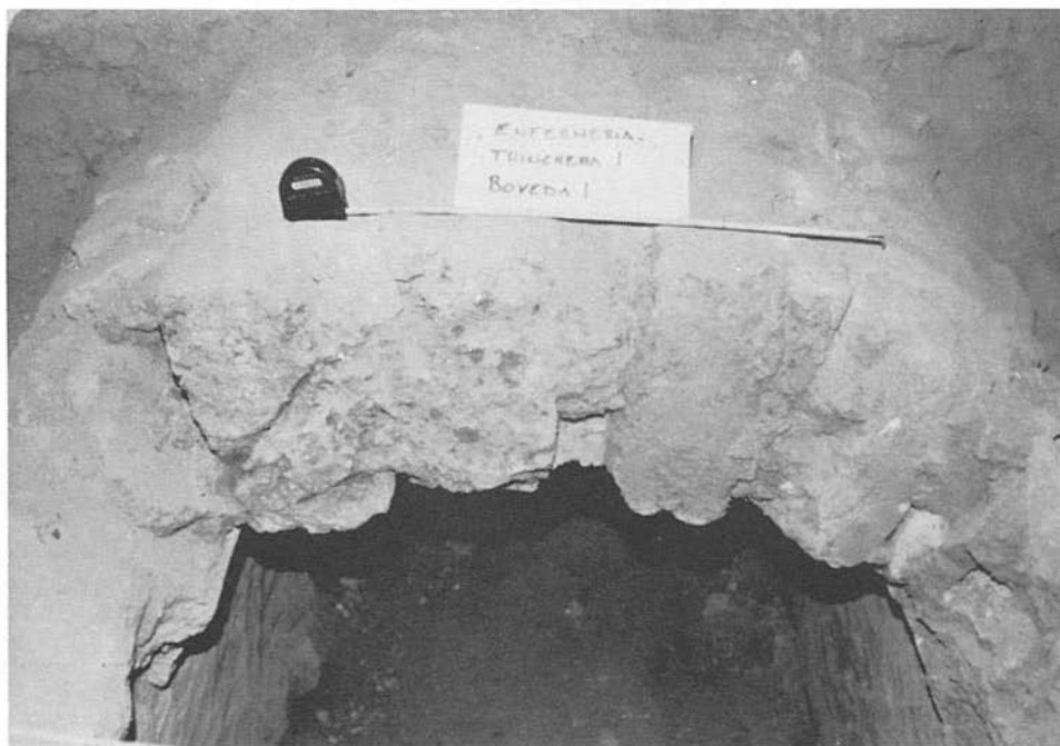
Bóvedas de adobe en el Hospital San Juan de Dios.
