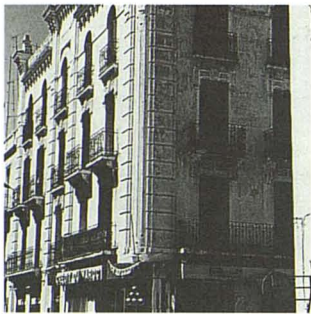
17 EDIFICIO DE VIVIENDAS Primera época. Arqs. Ovilo y G. Lescura Arquitectura tradicional Youssef ben Tachfin, 6
