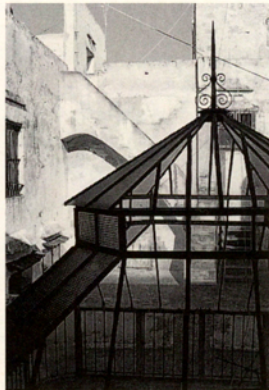
1 y 2. Estado anterior a la obra
