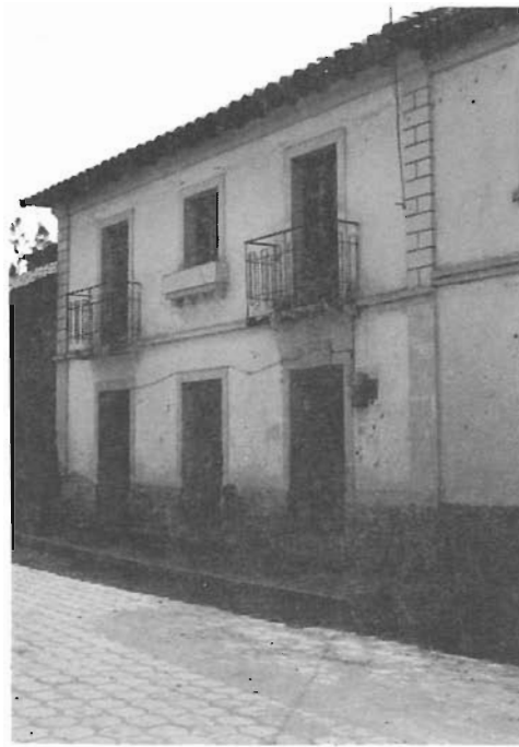
Guangopolo. Casas de ladrillo y adobe.
