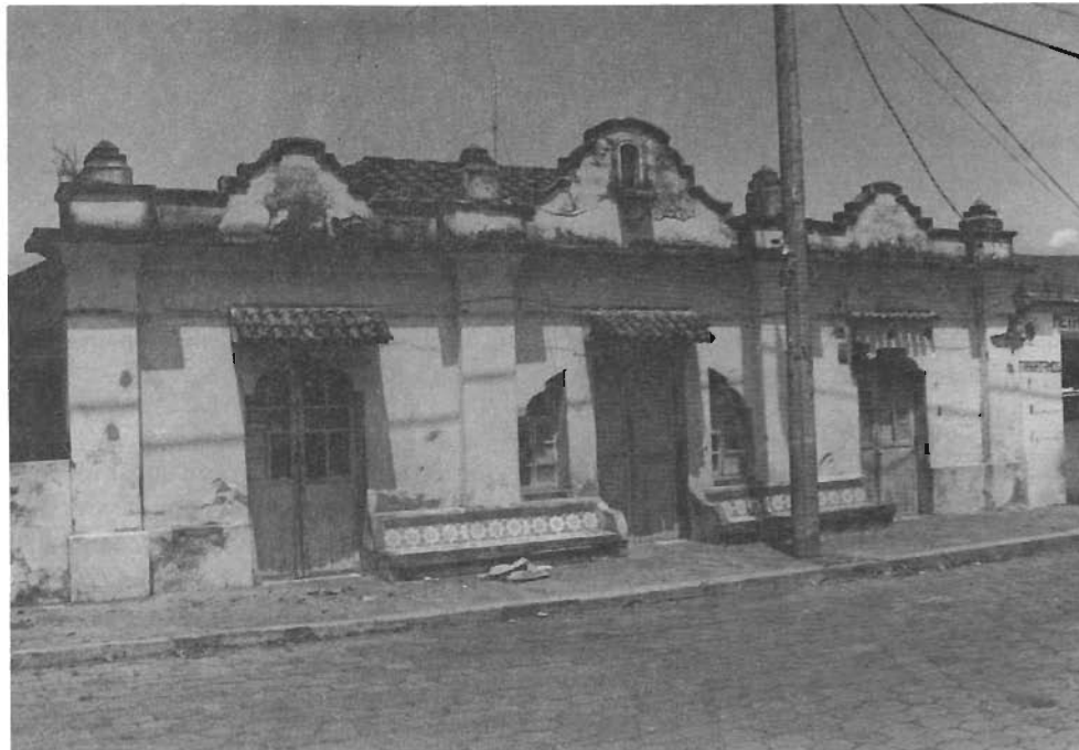
La Merced. Casa tradicional de adobe, tapial y piedra.
