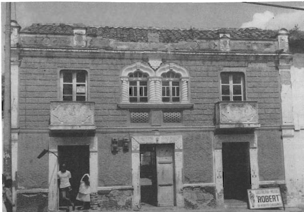
Pomasqui. Edificación frente al parque.
