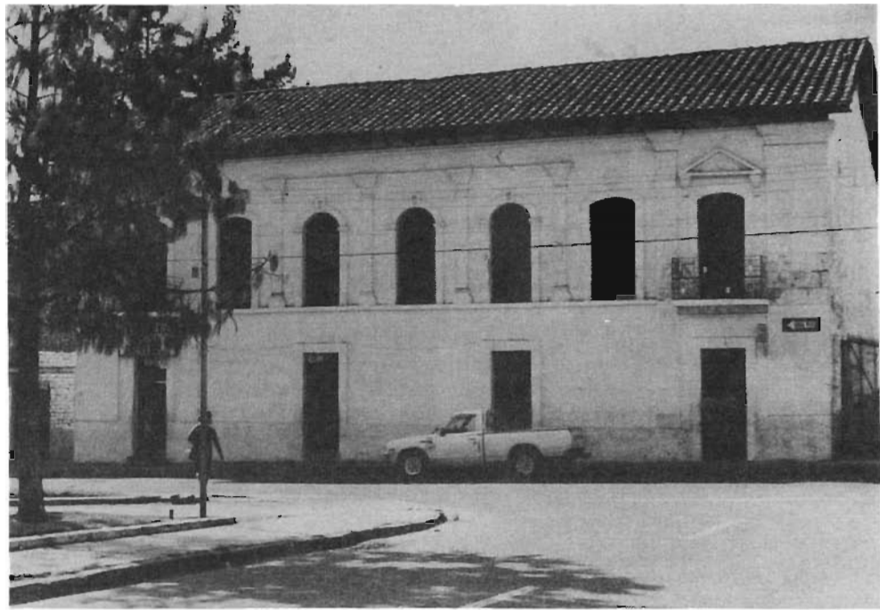
Chillogallo. Edificación tradicional.
