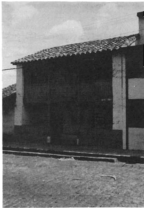
Alangasí. Vivienda en muros de adobe y cerramiento en madera.
