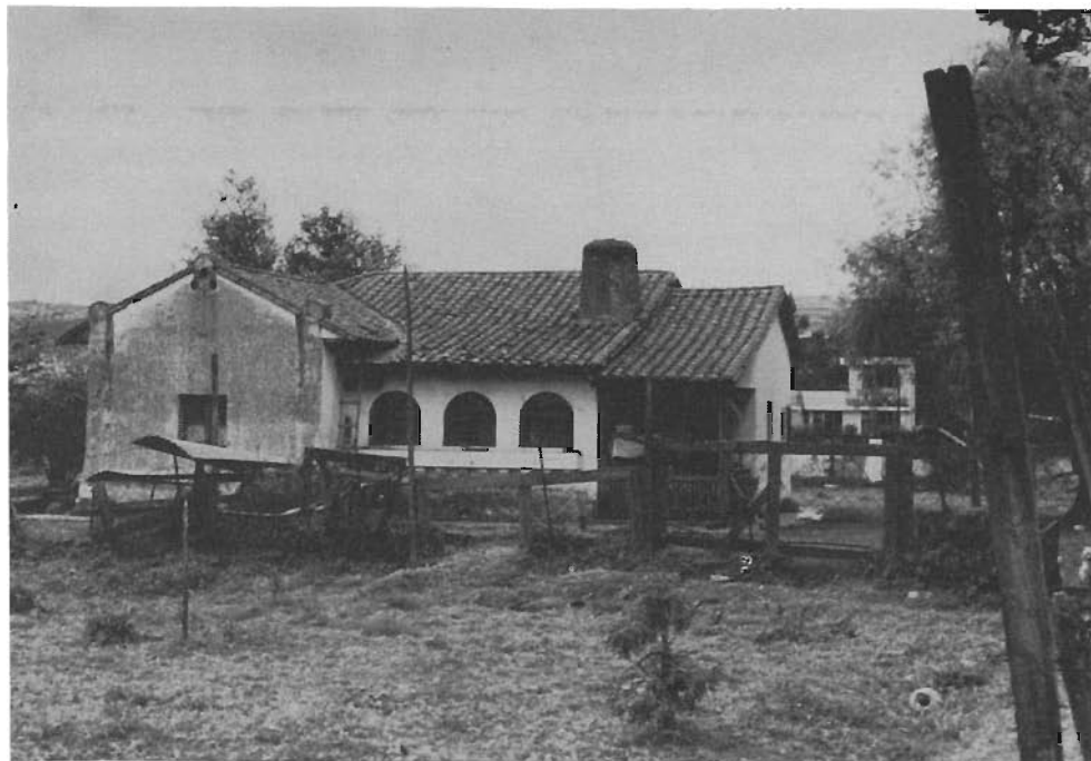
Chillogallo. Vieja casa de hacienda.
