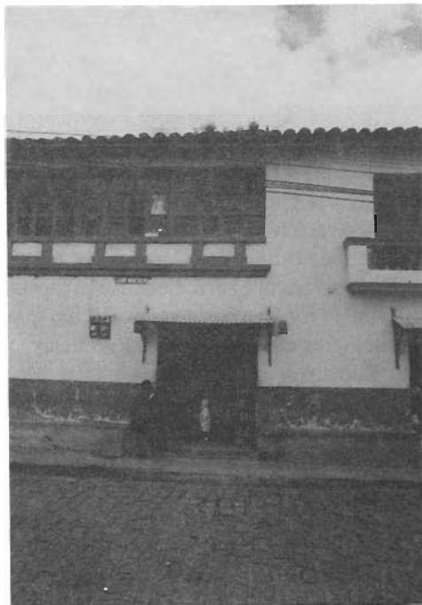
Tumbaco. Viviendas frente al parque.
