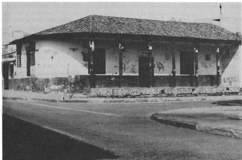
Chillogallo. Construcciones tradicionales simples.
