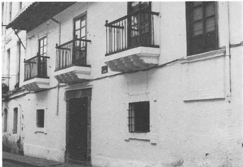
Casa en la calle Junín, se encuentran rosados y ocres debajo del blanco.
