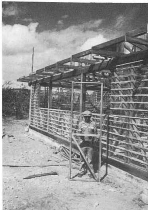
Bahareque, proceso de construcción, en Guayllabamba, del Centro de Tecnologías, Funhabit-AECI.
