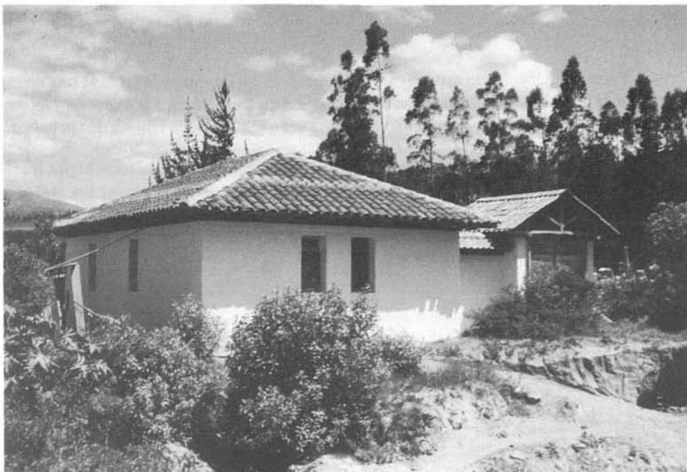
Construcción en terracemento. Funhabit-AECL.
