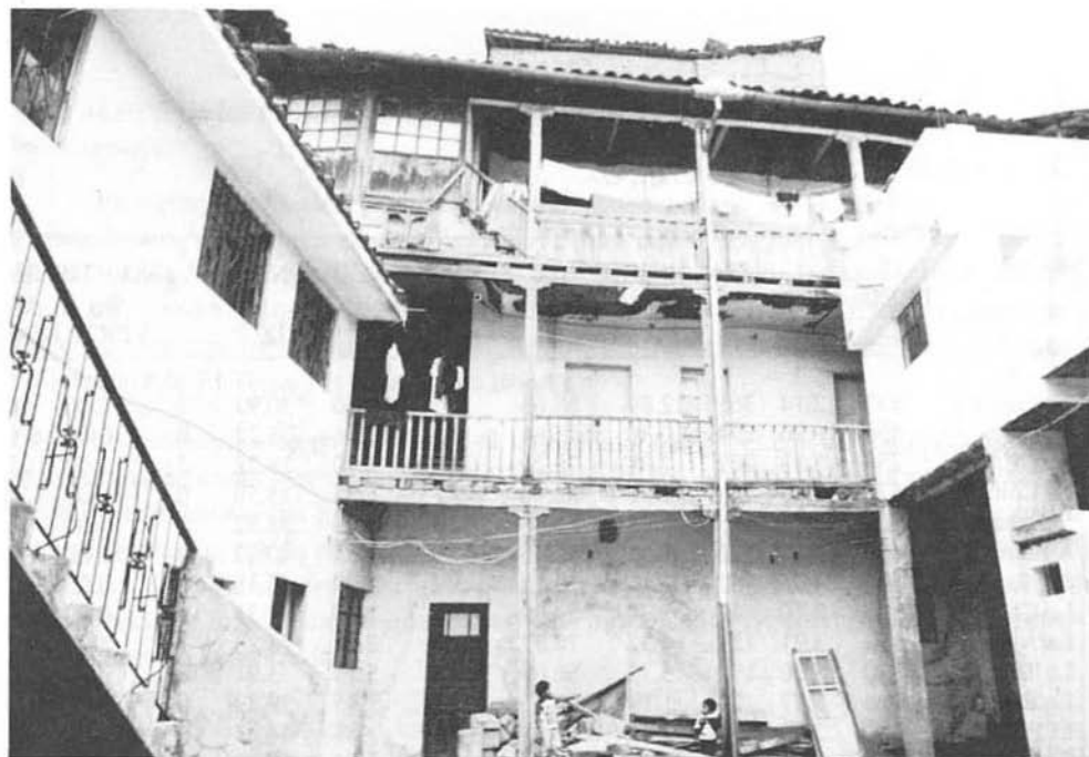
Patio de la casa situada en calle García Moreno 1636.
