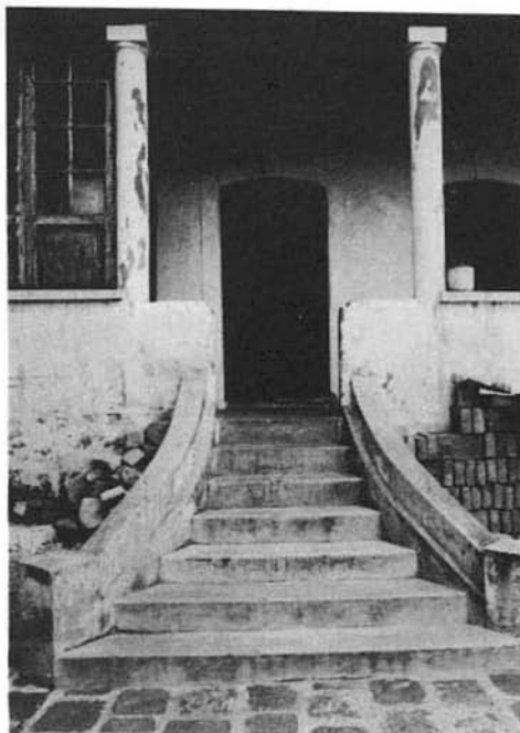
Centro Histórico de Quito. Antigua vivienda de la Loma.
