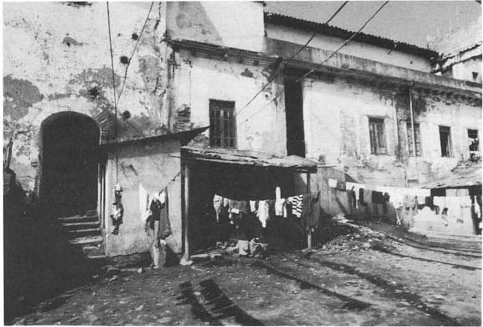
Precariedad de instalaciones eléctricas.
