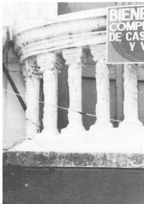
Detalle de balcón. El estudio estratigráfico identificó el uso de varios colores en ornamentos, marcos y dinteles.
