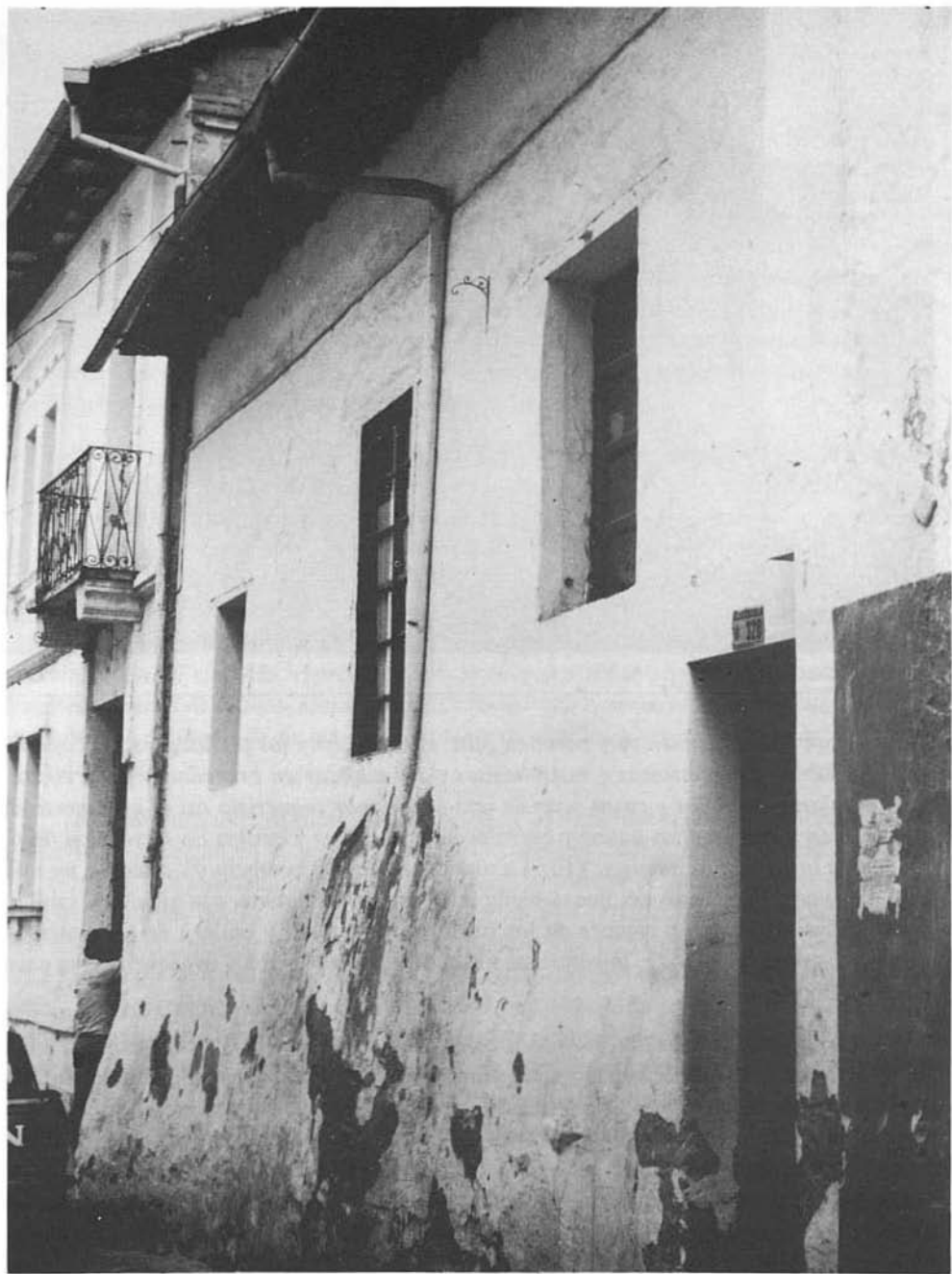
Antigua casa del Centro. Debajo del blanco se encontraron capas de pintura yuxtapuestas de colores rosado, blanco, amarillo y ocre.
