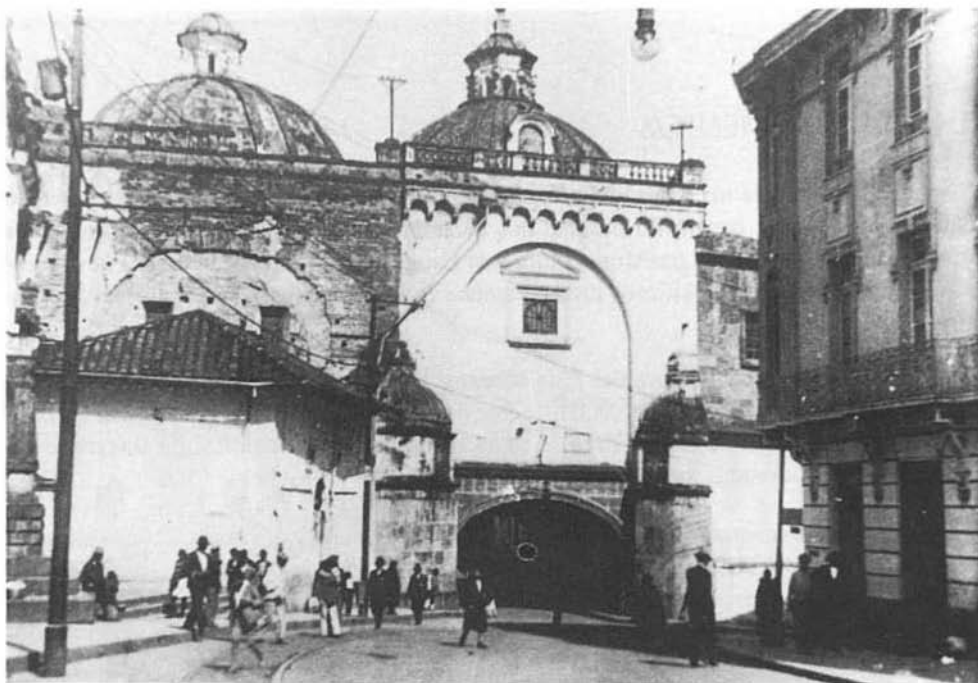
Arco de Santo Domingo, entrada a la Loma Grande. Foto Archivo Histórico del Banco Central del Ecuador.
