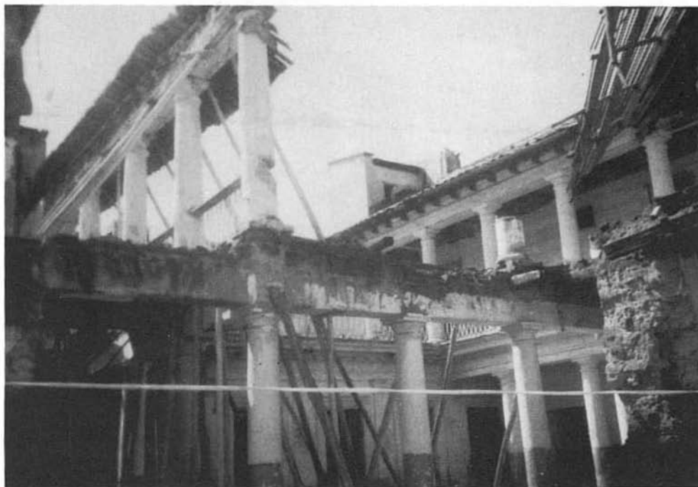
Centro Histórico de Quito. Casa del Toro en proceso de intervención para sede definitiva del Instituto de Capacitación Municipal, ICAM.
