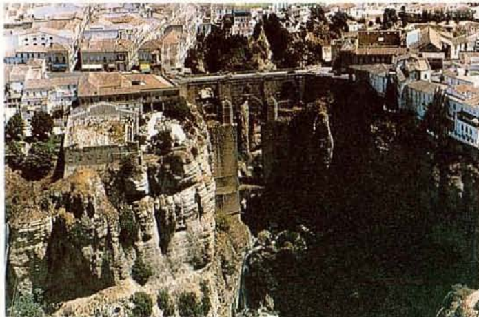
Puente nuevo y Parque del Tajo: vista desde el Oeste
