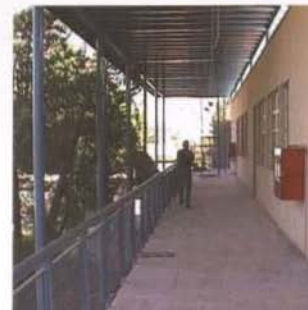
AMPLIACIÓN Y REMODELACIÓN COLEGIOS MUNICIPALES
