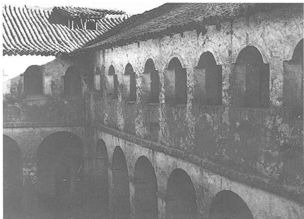
Figura 2. Claustro interior del convento de San Francisco. Cuzco.
