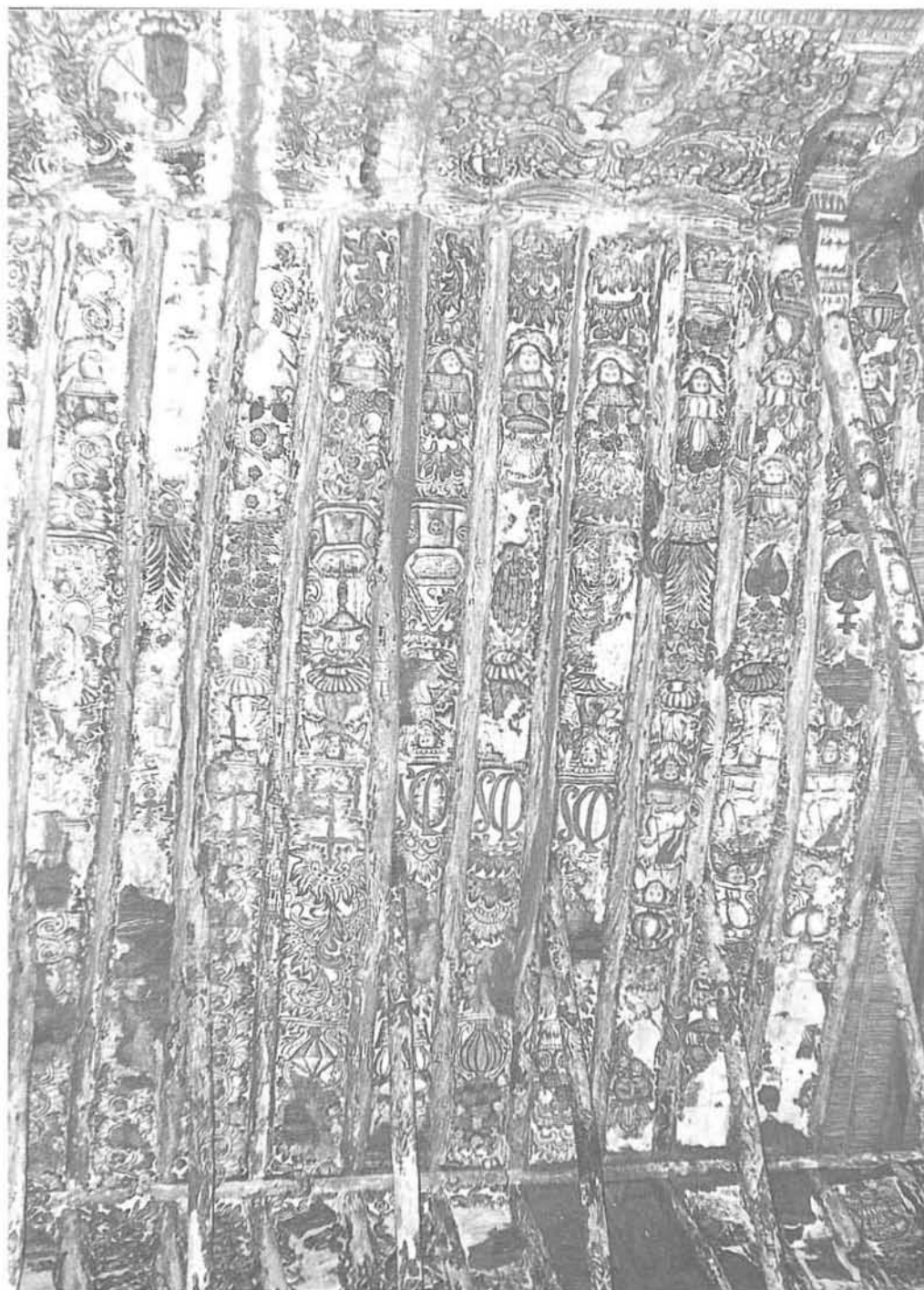
Figura 5. Huaró (Cuzco). Cubierta de la nave del templo.
