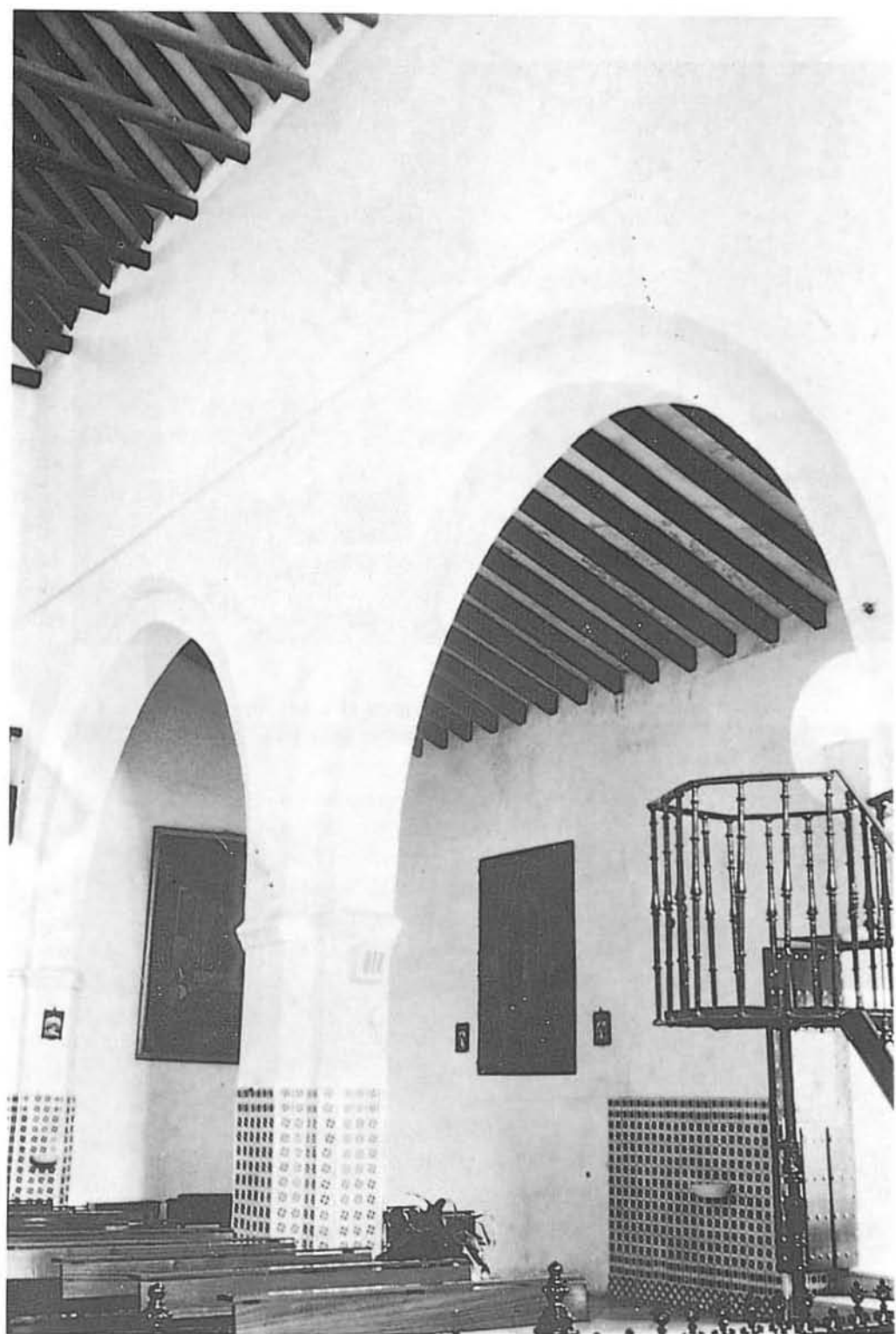
Figura 4. Interior de la iglesia del Hospital de San Lázaro de Sevilla. La fotografía recoge parte de la nave central y de una de las laterales, ambas con cubiertas de madera y separadas entre si por pilares revestidos de azulejos. La influencia mujéjar se hace patente. Foto E. Gómez Piñol.
