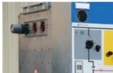
Colocación de ormalink
