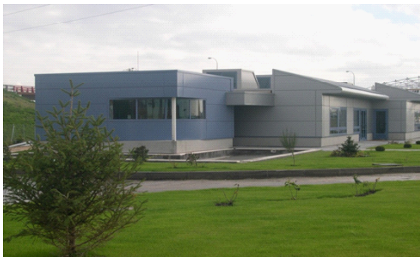
Figura 24: Centro de control, gestión y mantenimiento de la autopista M-45 de Madrid.
