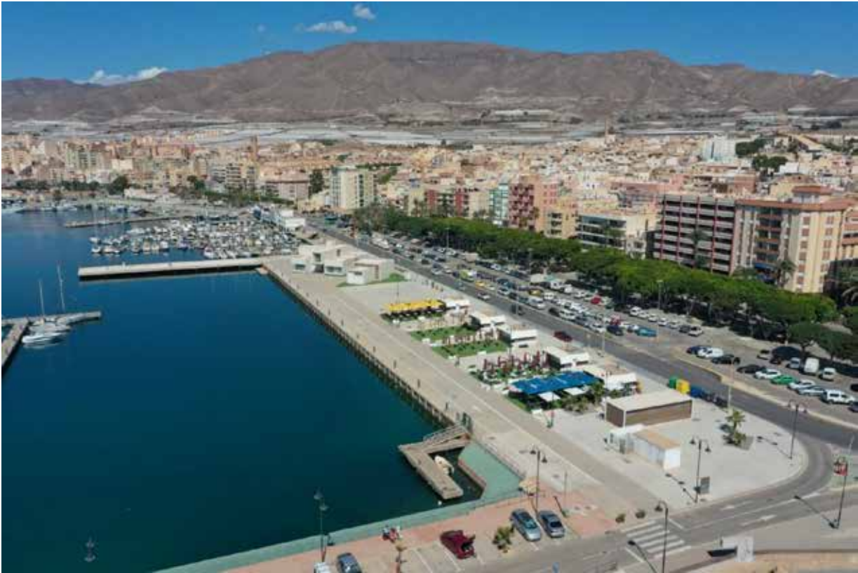
Adecuación del muelle de ribera (2022).
