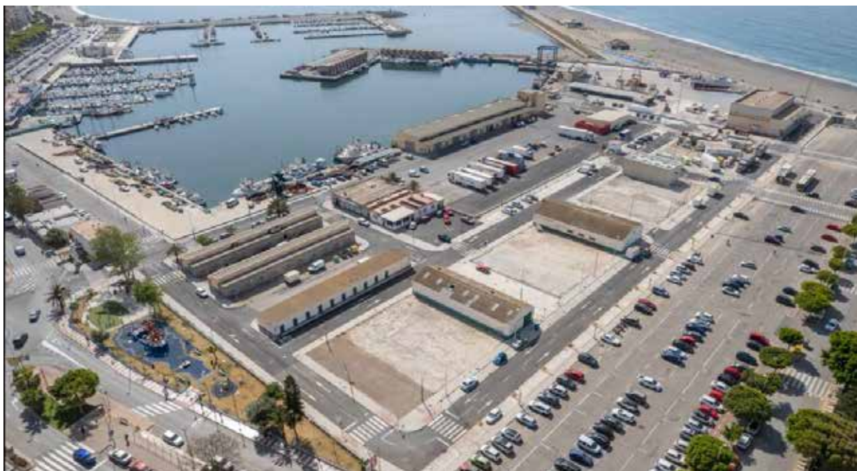
El Saladero. Segunda línea de explanada de poniente.
