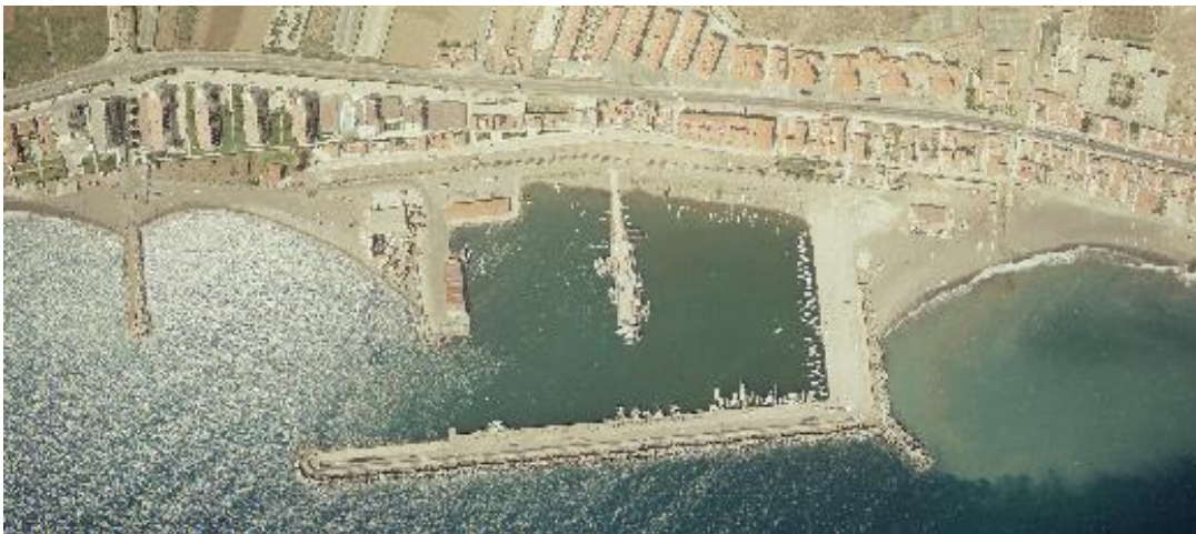
Junio 1990. El puerto con el muelle central. Fotografía aérea IGN
